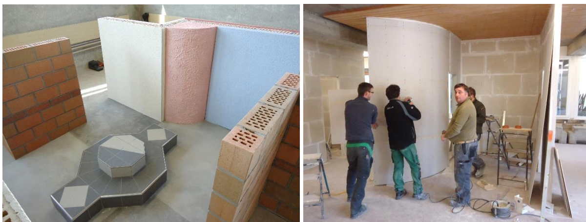
Materialvielfalt und Teamwork im Trockenbau (Fotos: BVKSG)
