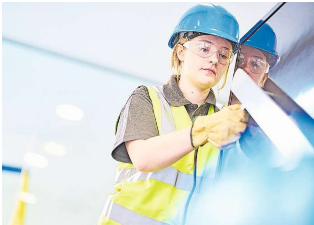
Eine Lernende montiert auf einer Baustelle einen Handlauf in einem Bürogebäude.
